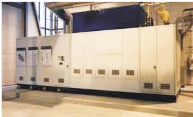
**Figura 4.** Instalação de células a combustível Siemens-Westinghouse de 100 kW de potência nominal (fotografia gentilmente cedida pela empresa)
