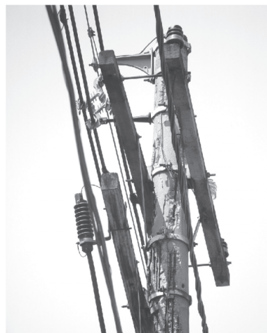
Figura 7. Foto destacando a corrosão generalizada da armadura de um poste de concreto de seção circular, com deslocamento da sua cobertura concretada
