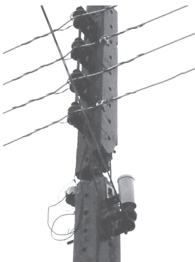
Figura 6. Poste, tipo duplo T, fraturado por esforços mecânicos superiores à resistência do concreto
