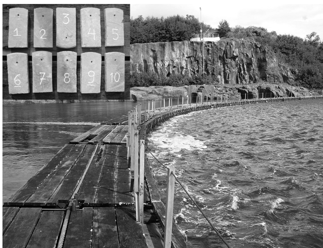
Figura 1. Vista geral do log-boom da UHE GJR. No detalhe, os CPs instalados
