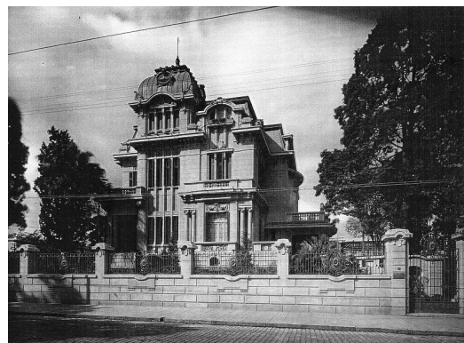
Figura 1. Fachada frontal (face norte) do Palacete Street, após a reforma. Alameda Glette, 463, São Paulo, SP, 1926/1927 (Foto: acervo da família Street, imagem digitalizada por Carlos Ribeiro Vilela, a partir de fotocópia do positivo original)
